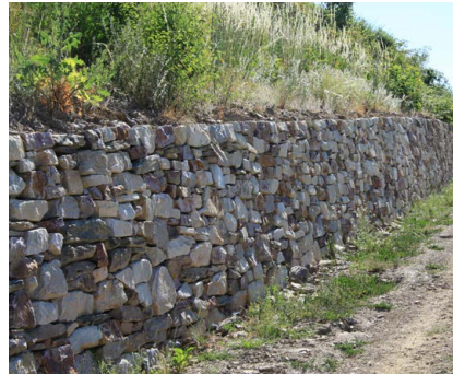
Abb. 10.2 Wiederhergestellte Trockenmauer bei Martinsthal (Foto: RP Darmstadt)
