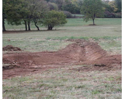
Abb. 1.2 und 1.3 Entfernung von Drainagen zur Wiederherstellung naturschutzfachlich hochwertiger Grünlandflächen (Foto links: RP Gießen, Foto rechts: Maik Sommerhage)
