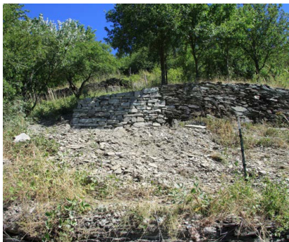
Abb. 10.3 Instandgesetzte Trockenmauer bei Lorchhausen (Foto: RP Darmstadt)
