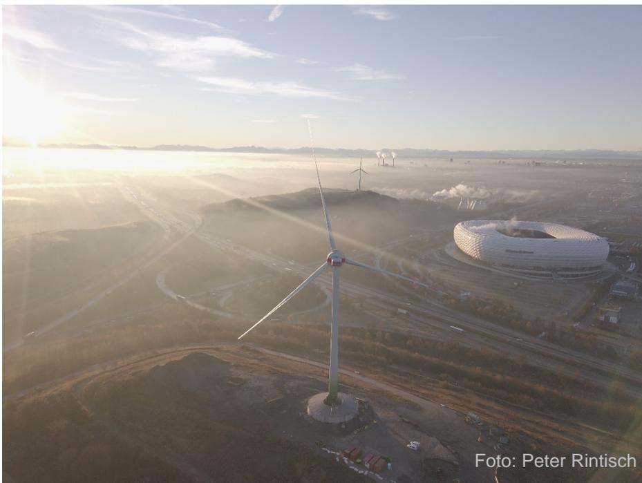
Sie steht auf der Deponie Nord-West im Stadtteil Freimann. Ihr Turm ist 80 Meter hoch, die Rotorblätter sind 69 Meter lang. Damit überragt die neue Windkraftanlage ihre „Schwester“ aus dem Jahr 1999 auf der anderen Seite der Autobahn deutlich. Auch bei der Energieproduktion liegt sie vorne: Mit rund 7,1 Millionen Kilowattstunden pro Jahr erzeugt sie genug Ökostrom für mehr als 2.800 Haushalte – etwa viermal so viel wie die ältere Anlage.
