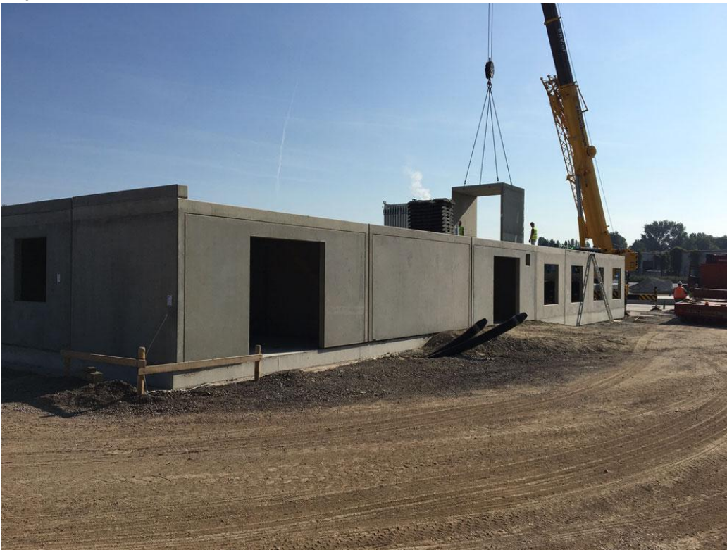
BU: Die Montage der 149 Fertigteile für den Wertstoffhof erfolgte in nur 10 Tagen. (Bild: Modulo Wertstoffhöfe GmbH)
