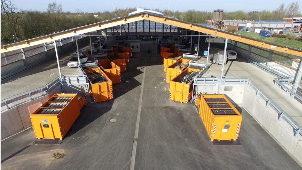
BU: Der aus Fertigteilen konzipierte Wertstoffhof in Herne bietet für den Besucher „Komfort“ auf zwei Ebenen. (Bild: Modulo Wertstoffhöfe GmbH)
