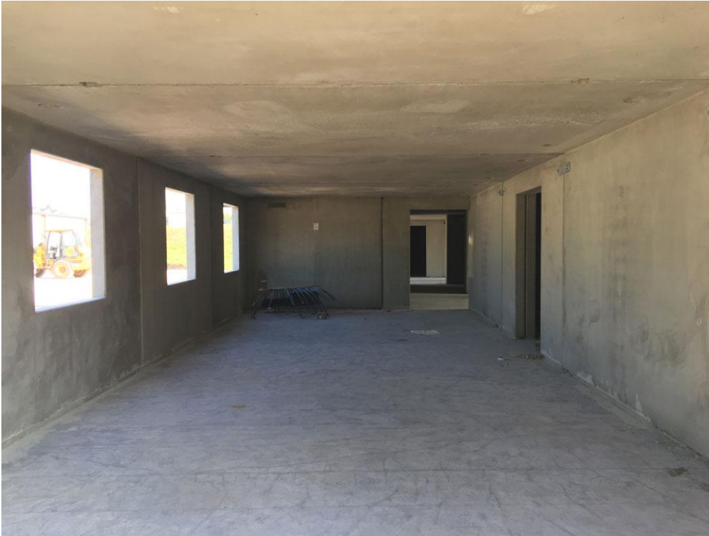
BU: Wie ganz normale Räume erscheinen die mobilen Einheiten von innen – trotz der Fertigteilbauweise. (Bild: Modulo Wertstoffhöfe GmbH)
