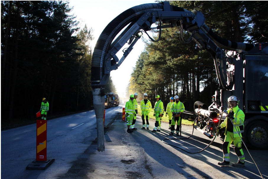
Für die eRoadArlanda wurde die Stromschiene direkt in der Straße verlegt. © eRoadArlanda
