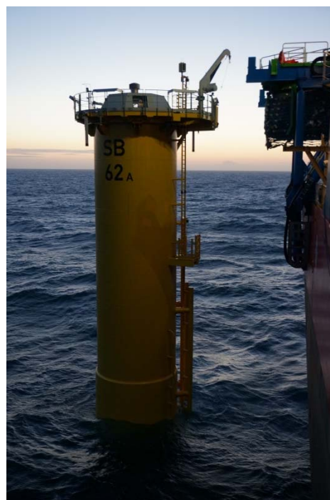
Das erste Stahlfundament des Windparks Sandbank ist gesetzt. Foto: Vattenfall
