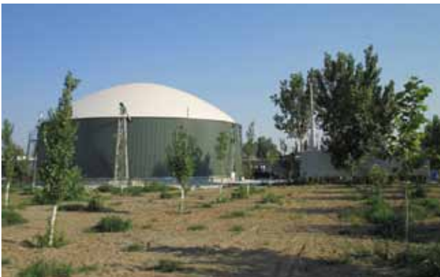
Sieben Edelstahl-Biogasanlagen mit einer Gesamtkapazität von 2,75 Megawatt hat WELTEC bislang in Griechenland gebaut.
