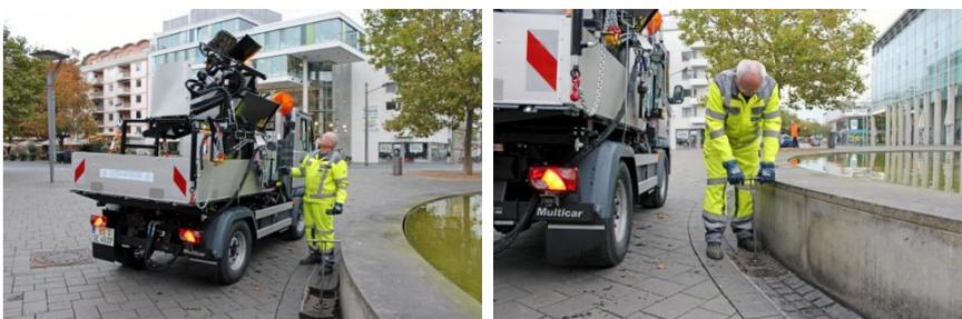
Darius Kucel von der Stadtentwässerung Braunschweig GmbH fördert einen Sinkkasten zur Reinigung nach oben – üblich beim Verfahren der „trockenen Reinigung“. Bei der „nassen Reinigung“ werden die Abläufe ausgesaugt.
