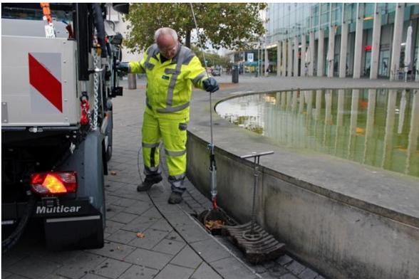
„Gully-Pflege“: Mit einem speziellen Hebegerät wird das Gitter über dem Sinkkasten abgehoben.
