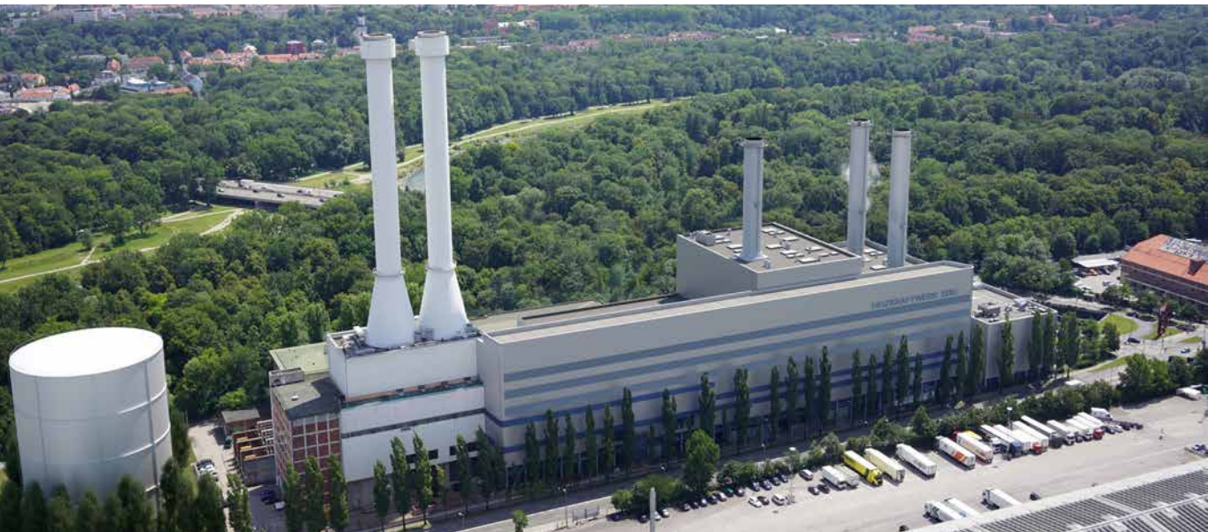
Am Energiestandort Süd nimmt 2021 Deutschlands größte Geothermieranlage ihren Betrieb auf.
