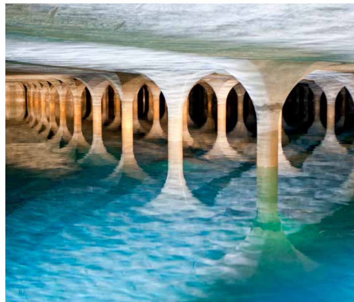
Der Hochbehälter Forstenrieder Park sammelt Trinkwasser aus den Gewinnungsgebieten.
