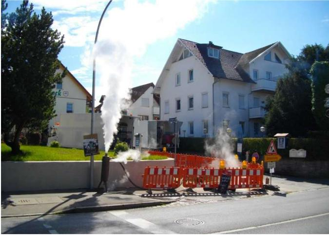
Bei der Erhitzung der U-Liner-Rohre tritt Wasserdampf an den Rohrenden aus.
